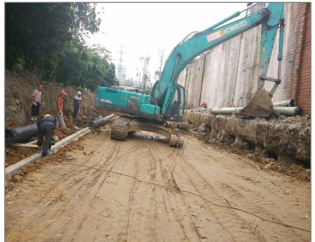
挡墙基础完成墙体开始上升
