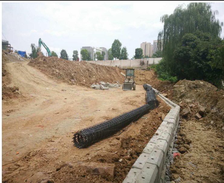
挡墙施工进行中
