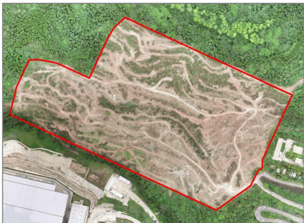
工程建设前场地卫星图
