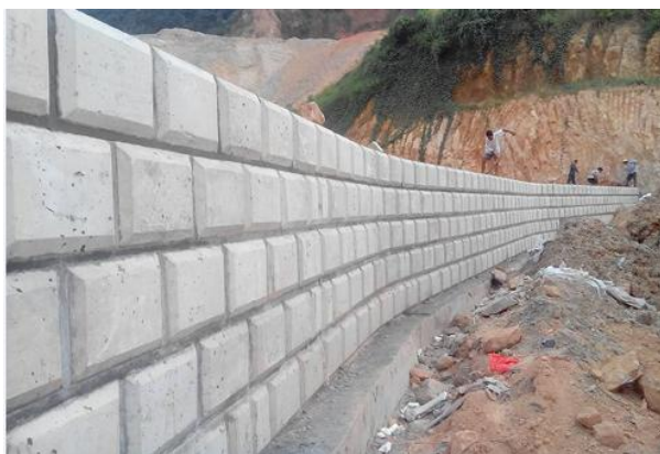
Y型预制块安装成形的效果
