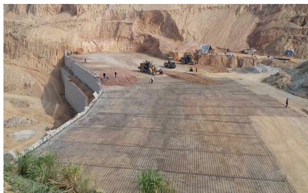
挡墙施工第 2 阶
