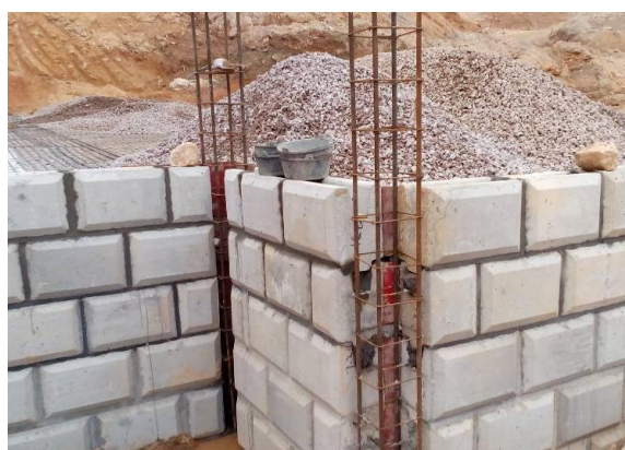
挡墙转角处采用构造柱处理
