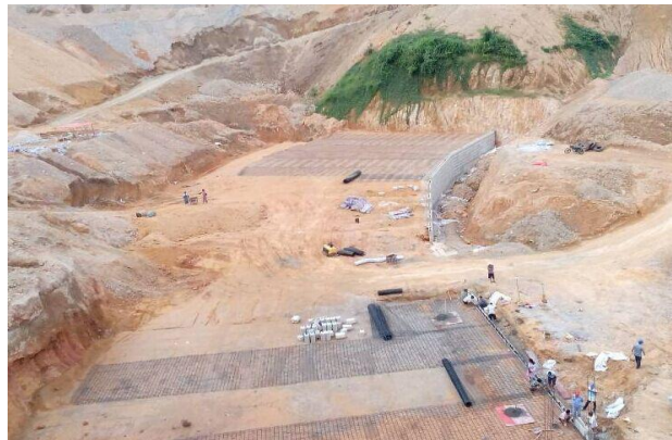
挡墙施工第 1 阶
