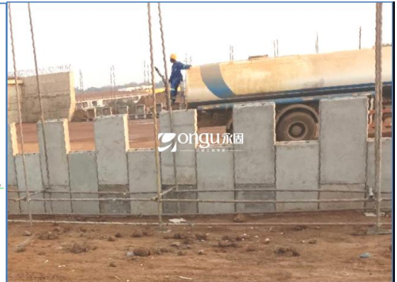
墙面预制板安装中
