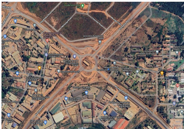
工程建设前环岛卫星图
