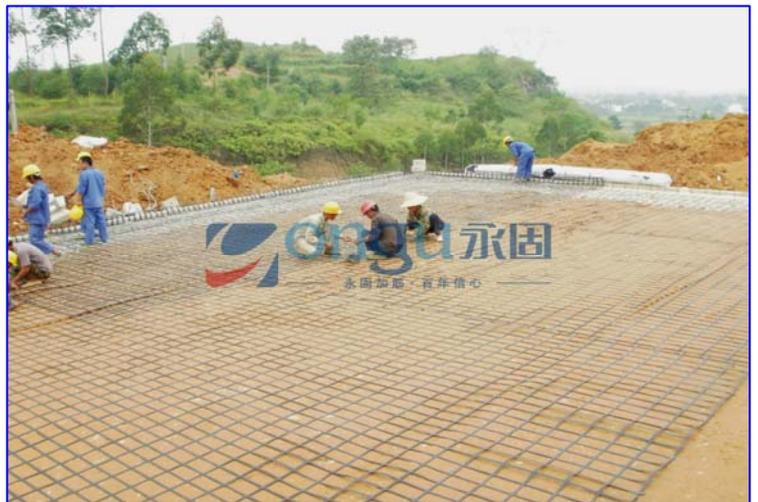
(3) 加筋填料：级配良好的碎石土，粒径大于 60mm 颗粒的质量超过总质量的 50%，最大粒径
